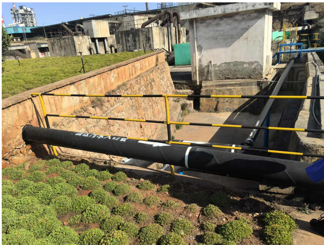
图 2 园区污水入口
